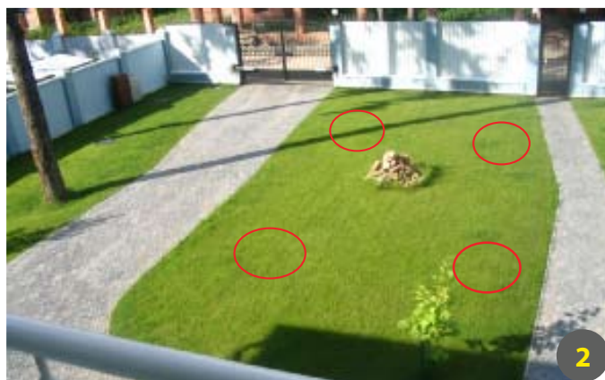
2. Разметка скважин. Для закладки геотермальных зондов были отведены перед домом две лужайки общей площадью 80 кв.м
